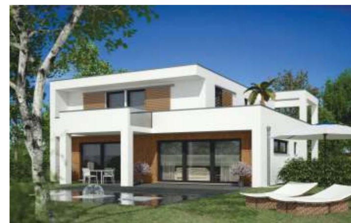
architektonisch anspruchsvolle Fassaden
