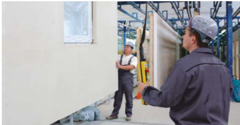
Die Wände werden in der Fabrik vorgefertigt...
