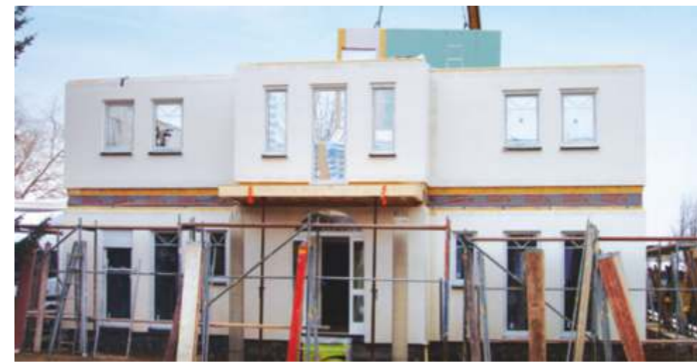
Anschließend wird das Obergeschoss aufgesetzt.
