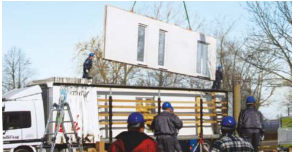
... auf LKW zum Bauplatz transportiert...
