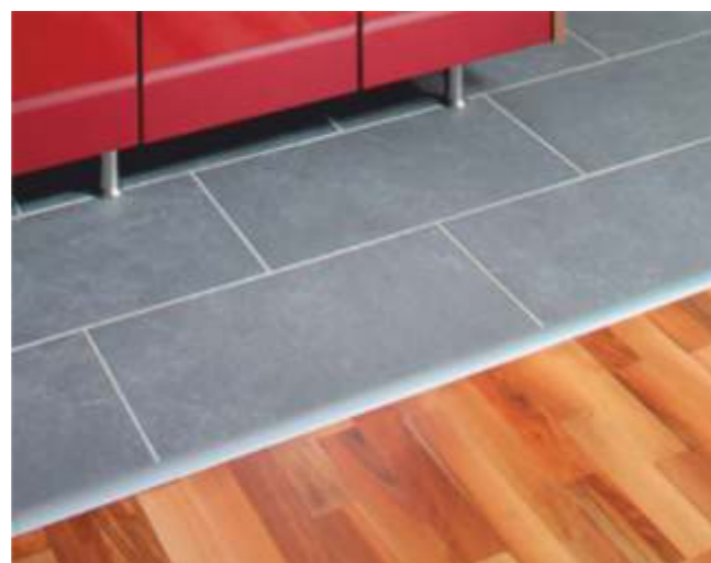
Übergänge zwischen zwei verschiedenen Bodenbelägen werden mit einer Fußbodenleiste kaschiert.
