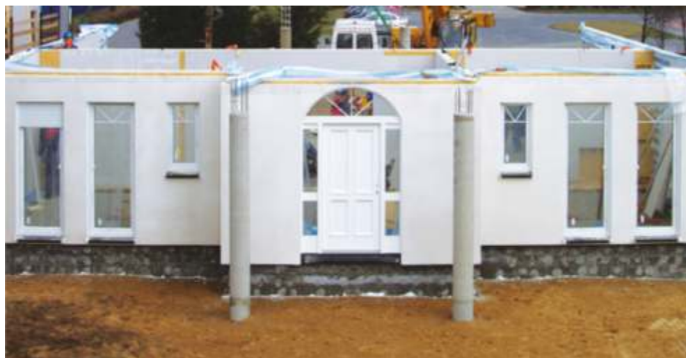
...und das Erdgeschoss auf das Fundament montiert.
