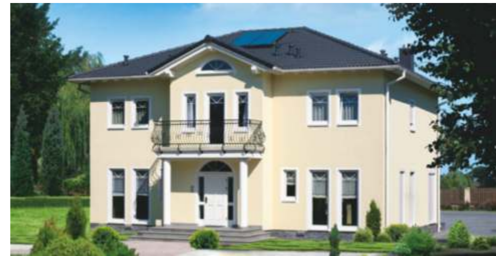
Nach ca. 15 Wochen ist die Villa fertig...
